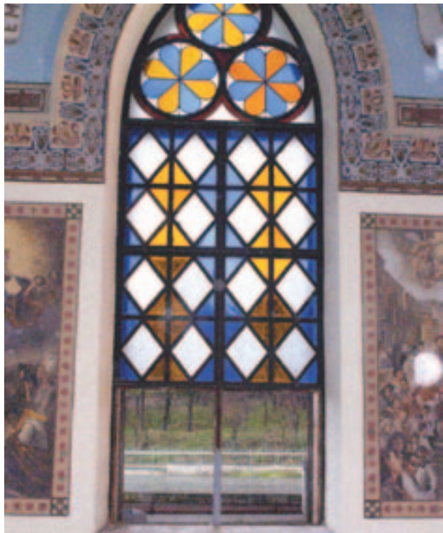
L'antico finestrone ogivale prima del restauro. Da notare la parte inferiore mancante.
